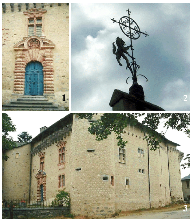
1 - La porte d'entrée du château en grès rose
